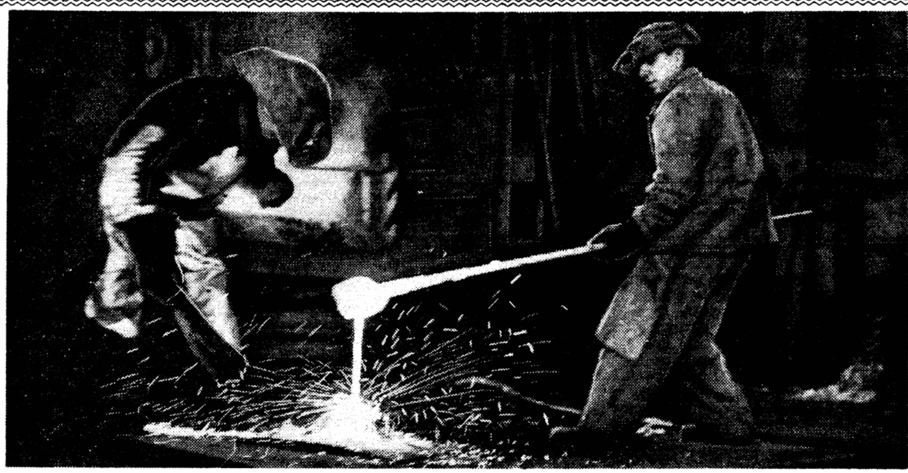
Идет сталь второго года семилетки. Знатный сталевар завода «Электросталь» бригадир Петр Гурев (справа) и его подручный берут пробу металла.
